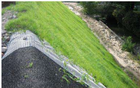
Рис. 7. Укрепление склона травянистой дернообразующей растительностью
