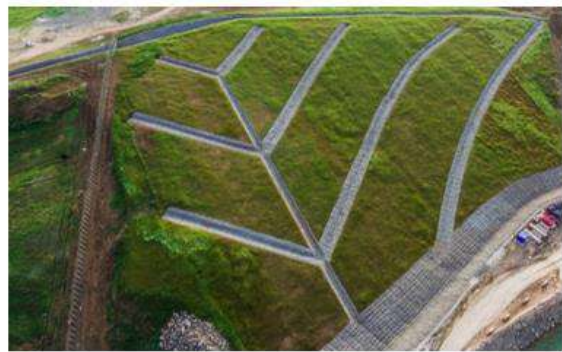
Рис. 8. Осушение оползневого склона
